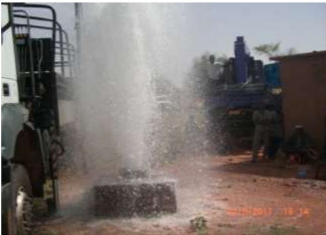
Opération de nettoyage du forage à l'air lift
