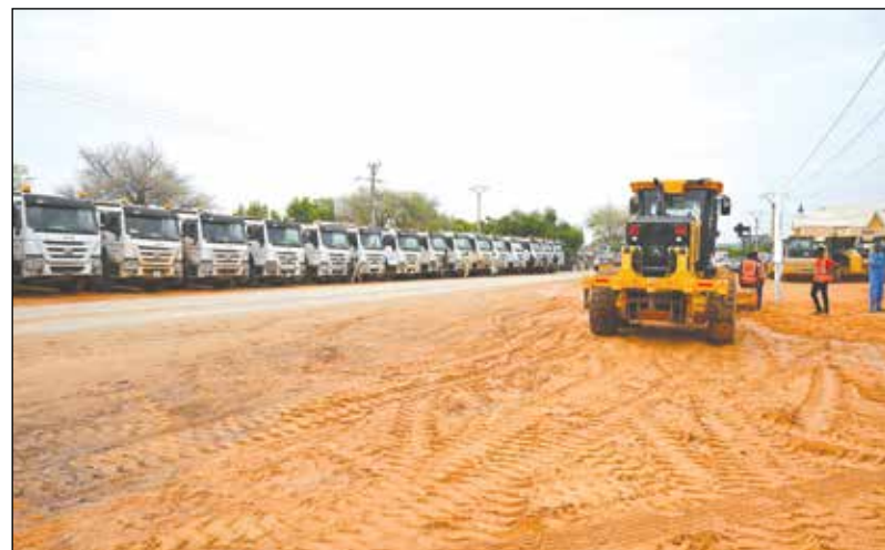
Les engins mobilisés pour le démarrage des travaux
