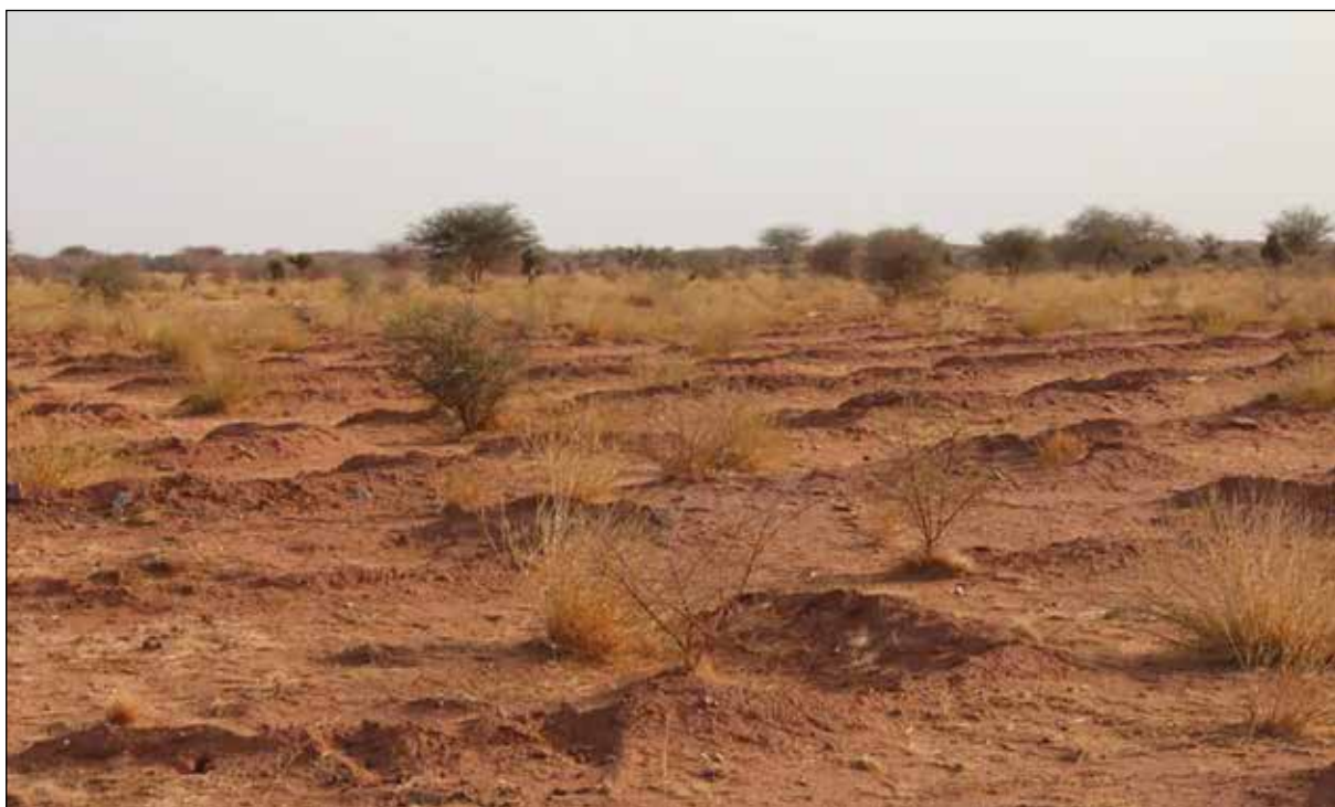
Vue d'ensemble des aménagements en demi-lunes réalisés pour la restauration des sols et la rétention des eaux de pluie
